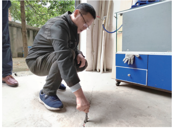
业主把一根1.2米长的钻头插入车库裂缝区域,仅剩下一小截。 记者/易楚瞳 摄
