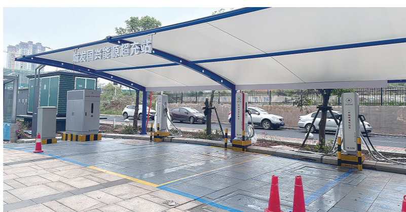
我市首个新能源超充站落成。
