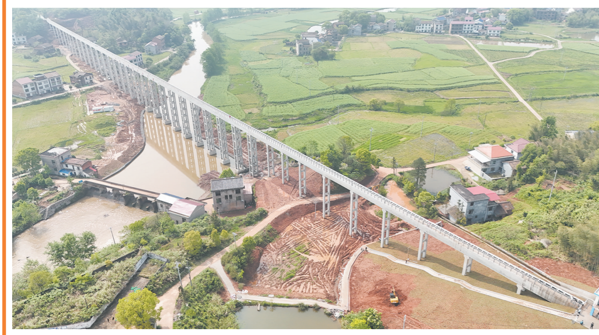
跃进渡槽顺利通水。记者/王军 通讯员/谭琦 摄
