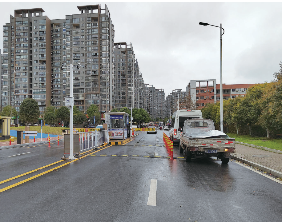
工大西街延伸段与泰山西路交汇处的收费岗亭。记者/易楚瞳 摄
