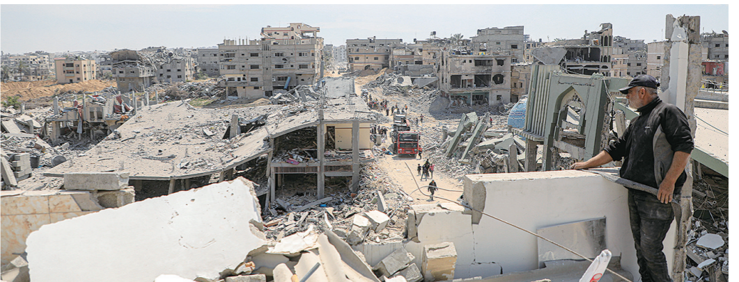
8日，在加沙地带南部城市汗尤尼斯，人们经过损毁的建筑。新华社发(里泽克·阿卜杜勒贾瓦德 摄)
