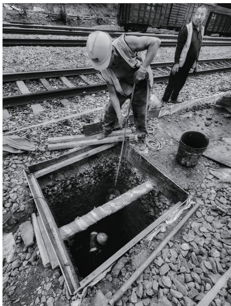
工人在旧址路段改造施工。
