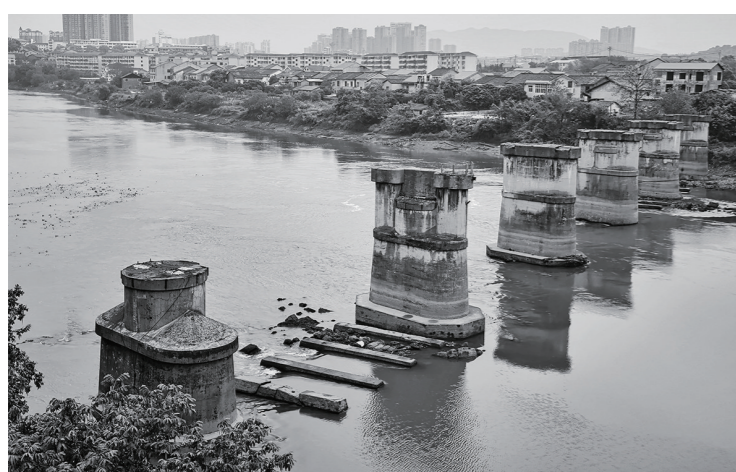
溁江上的株萍铁路老桥墩。
