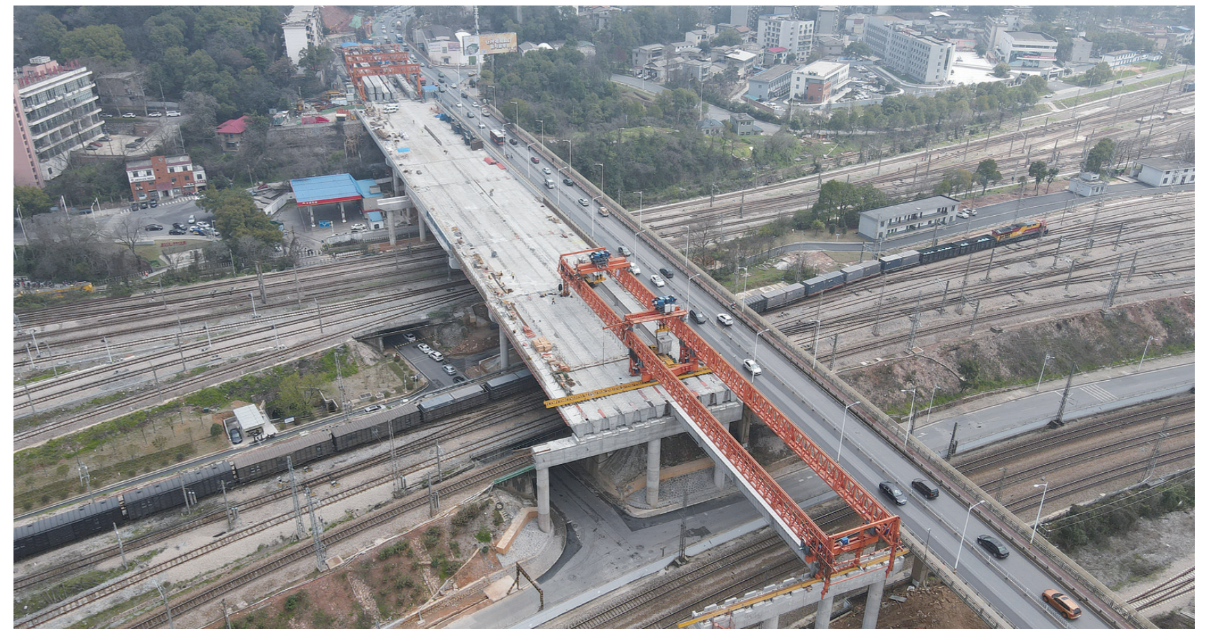
新桥梁开始倒数第二跨箱梁架设。记者/张威 摄
