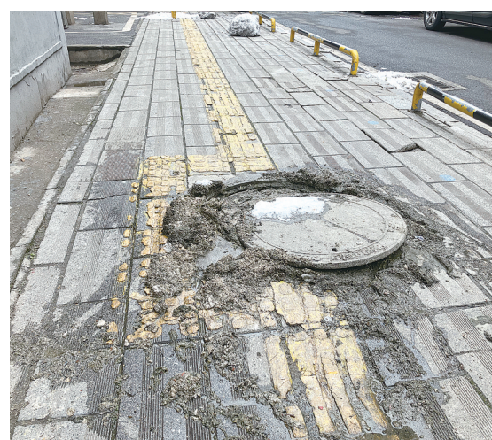
1月24日,学堂冲二村5栋旁下水道堵塞,污水漫出井盖,脏乱不堪。
