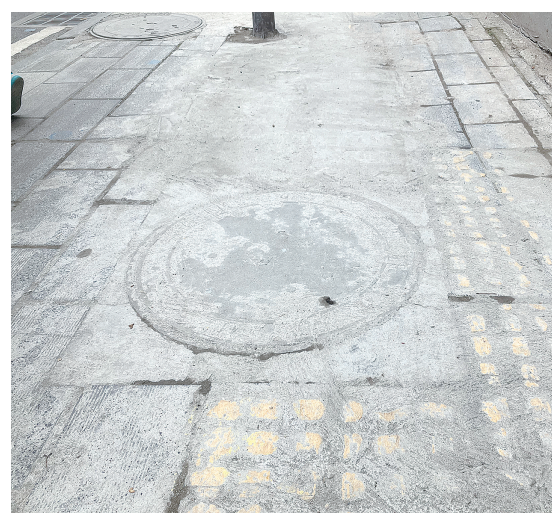
3月8日,经过疏通,学堂冲二村5栋旁下水道不再冒污水。
