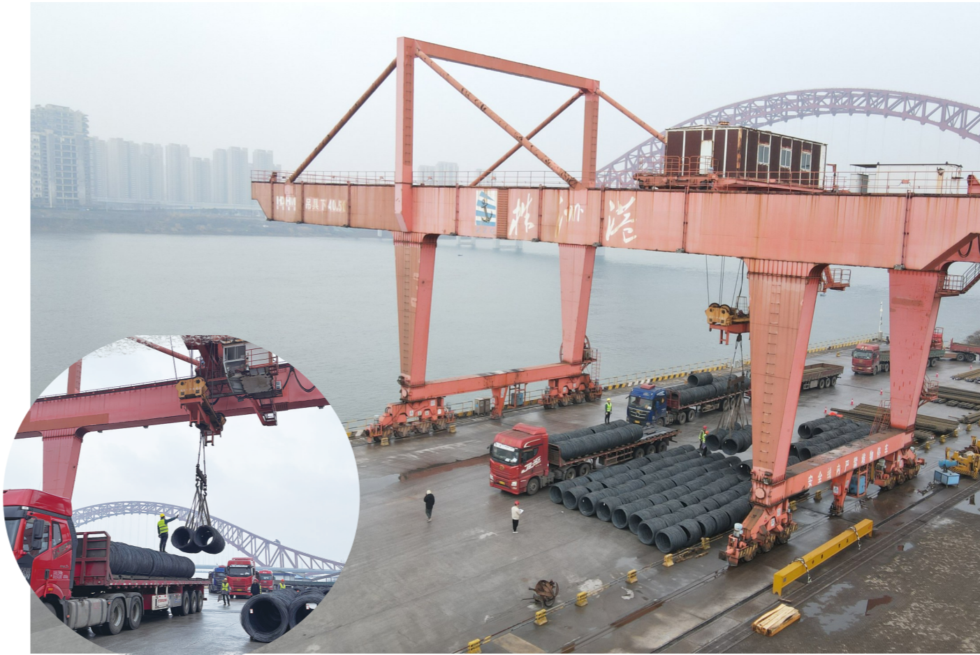
▲工作人员正在卸下湘潭拉来的钢材。
