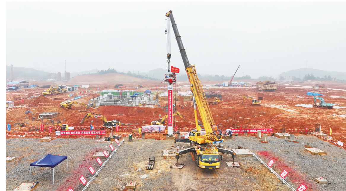
大唐华银株洲发电有限公司2×100万千瓦扩能升级改造项目1号锅炉钢架开吊。 企业供图
