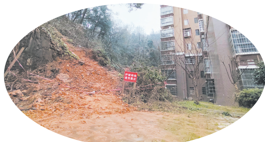
事发多年后,云溪谷小区6栋附近山体滑坡痕迹犹存。记者/易楚瞳 摄
