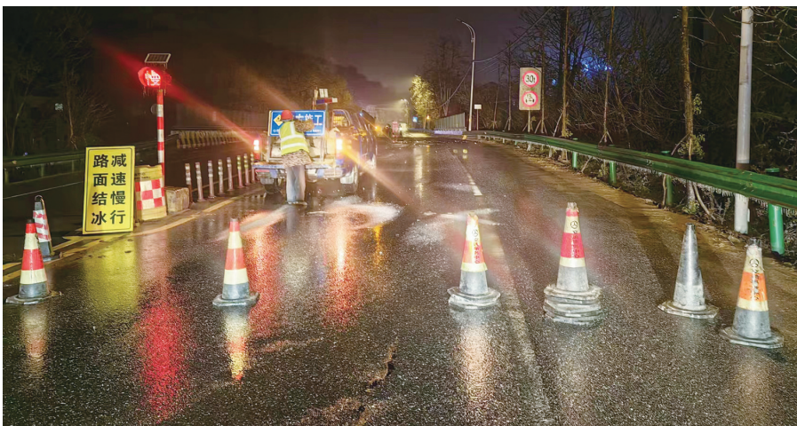
夜幕下开展防除冰作业,通讯员 供图
