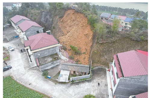
边坡崩塌现场。受访单位供图
