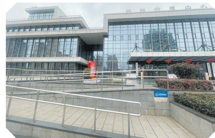
市民中心外的无障碍坡道，让有需求的群体出行更安全顺畅。 记者/伍靖雯 摄
