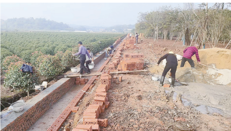
村民正在修建鸡嘴山社区灌溉水渠。
