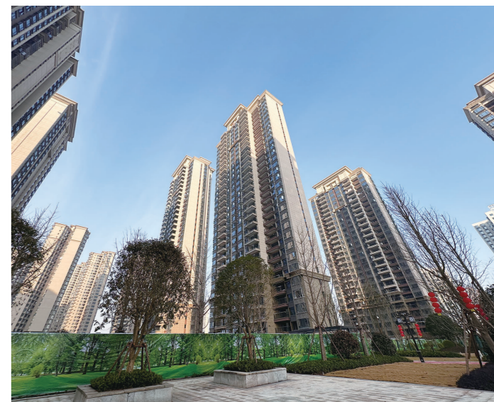
位于天元区恒大·悦珑台的“保交楼”项目已进入施工尾声。记者/张威 摄
