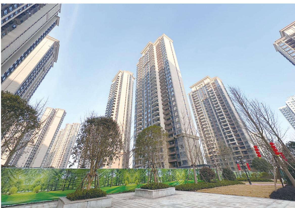
位于天元区恒大·悦珑台项目的“保交楼”项目已进入施工尾声。记者/张威 摄
