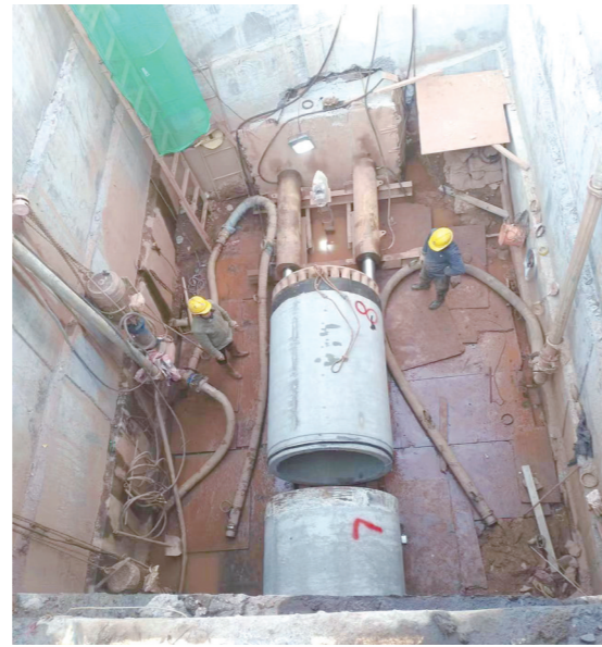
报亭南路沿线通过新建排水管道，消除内涝隐患。 受访部门/供图
