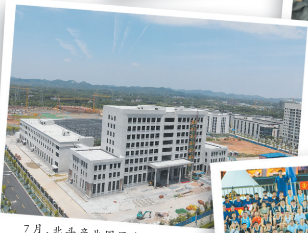
7月,北斗产业园区赛德雷特卫星工厂项目迎来一期主体封顶。 株洲日报全媒体记者/张威 摄
