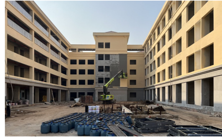
12月28日,大楼的外墙粉刷施工在进行。 记者/刘平 摄
