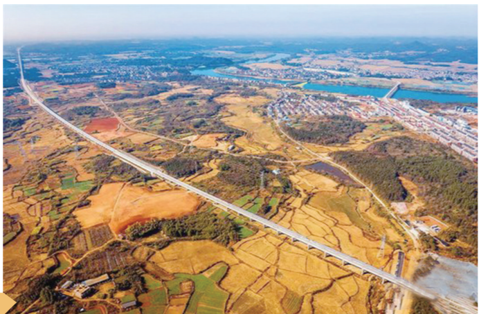
横跨在赣鄱大地的杭昌高铁。
