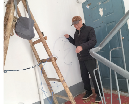
陈序象在维修照明线路。 记者/杨如 摄
