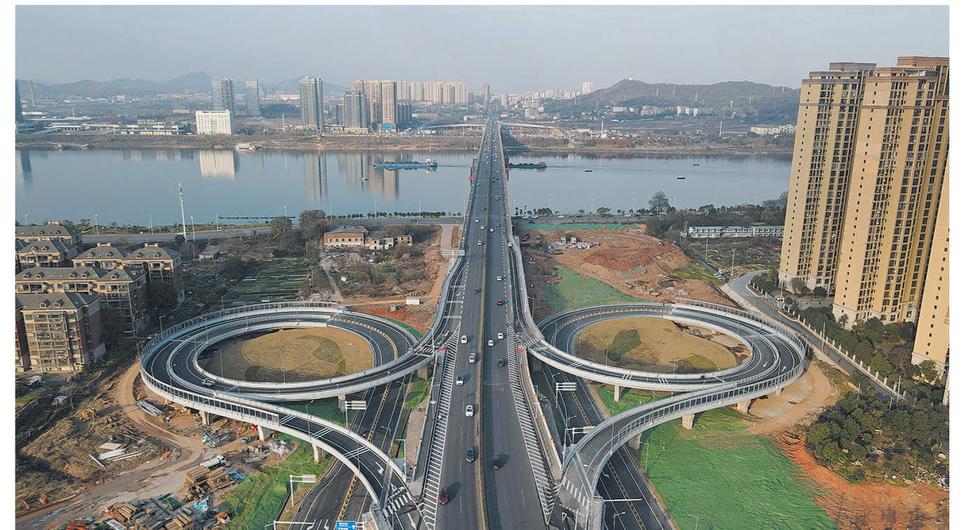
▲石峰大桥西匝道项目总投资2.1亿元
