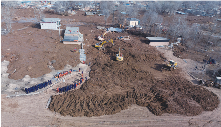
12月19日,救援机械和人员在青海民和县中川乡金田村清理地震引发的砂涌。
