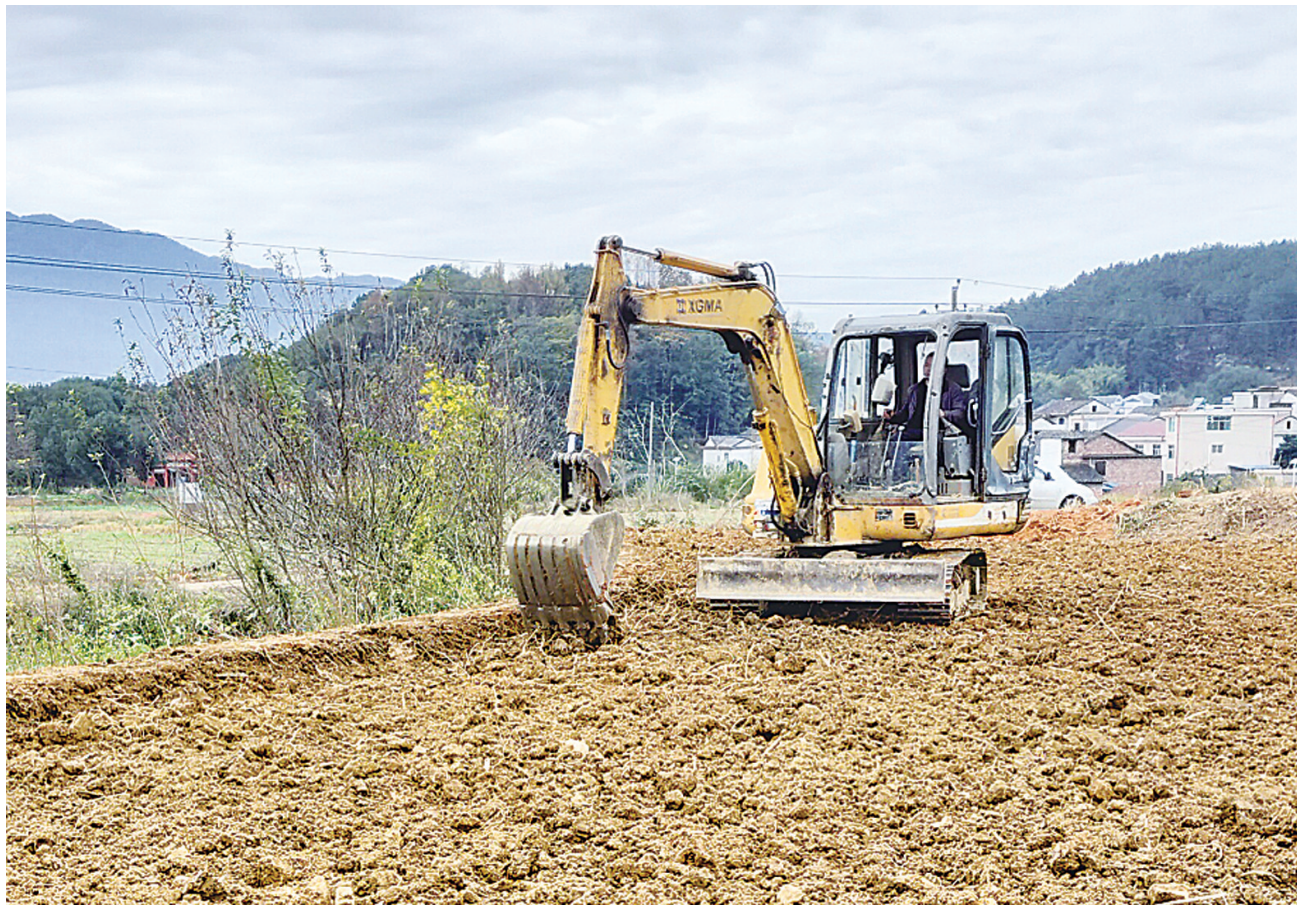
鹿原镇炎陵村果园移除恢复施工现场。廖圆 摄
