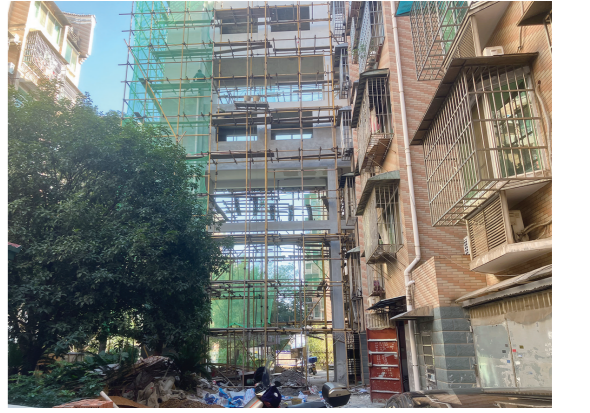
天台小区25栋1单元正在加装电梯。 记者/姚时美 摄
