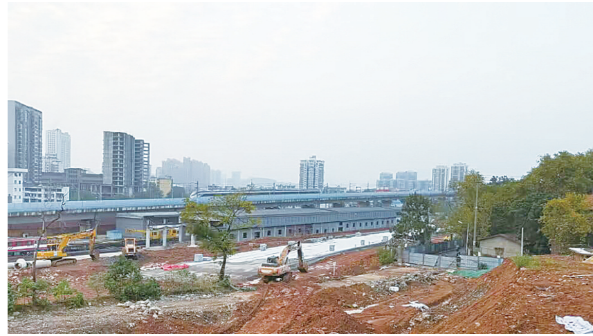
铁东路施工现场附近,一列从长沙开来的城际列车驶过。
