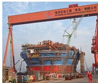
近日,由我国自主设计建造的亚洲首艘圆筒型“海上油气加工厂”——“海洋石油122”浮式生产储卸油装置(FPSO),在青岛进入最后的总装集成冲刺阶段。据介绍,“海洋石油122”船体直径约90米,设计排水量10万吨,可连续海上作业15年不回坞。
