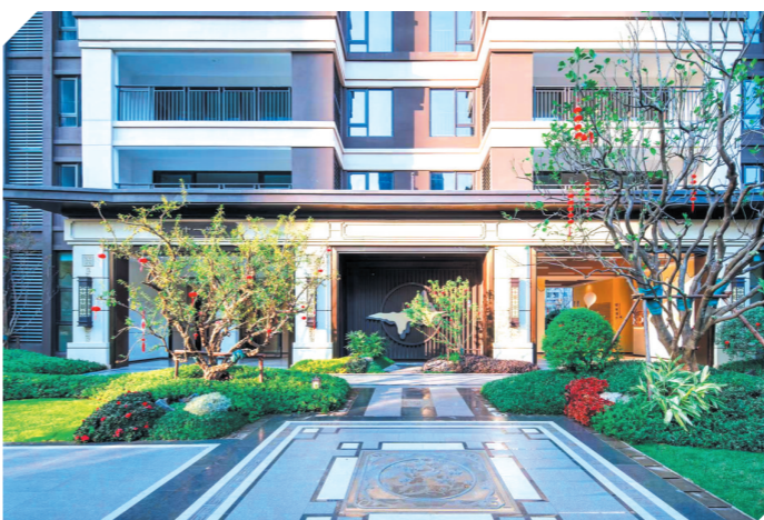
▲株洲建发央著项目实景。建发央著供图
