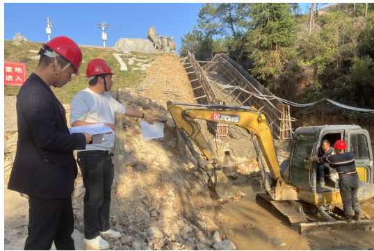
四季坑水库除险加固工程正紧张施工。黎世伟 摄
