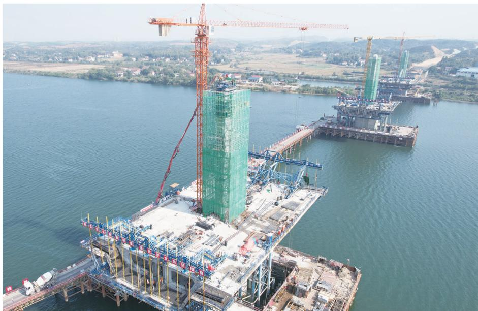
醴娄高速湘江株洲特大桥梁13号墩索塔封顶浇筑现场。通讯员/吕伟 摄
