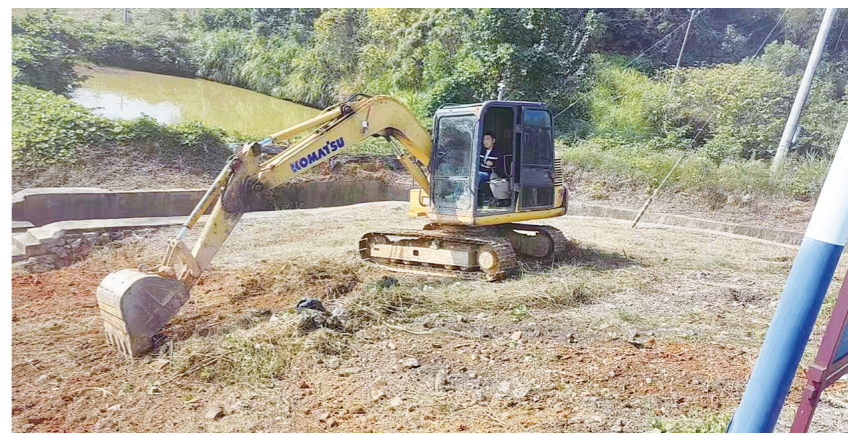
水库除险加固现场。通讯员 供图
