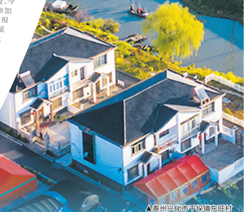
▲泰州兴化市千垛镇东旺村
