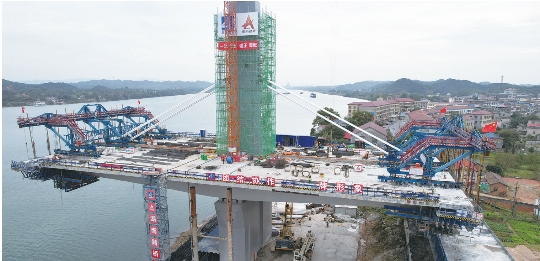
醴娄高速湘江株洲特大桥首对斜拉索已安装完成。通讯员/吕伟 摄
