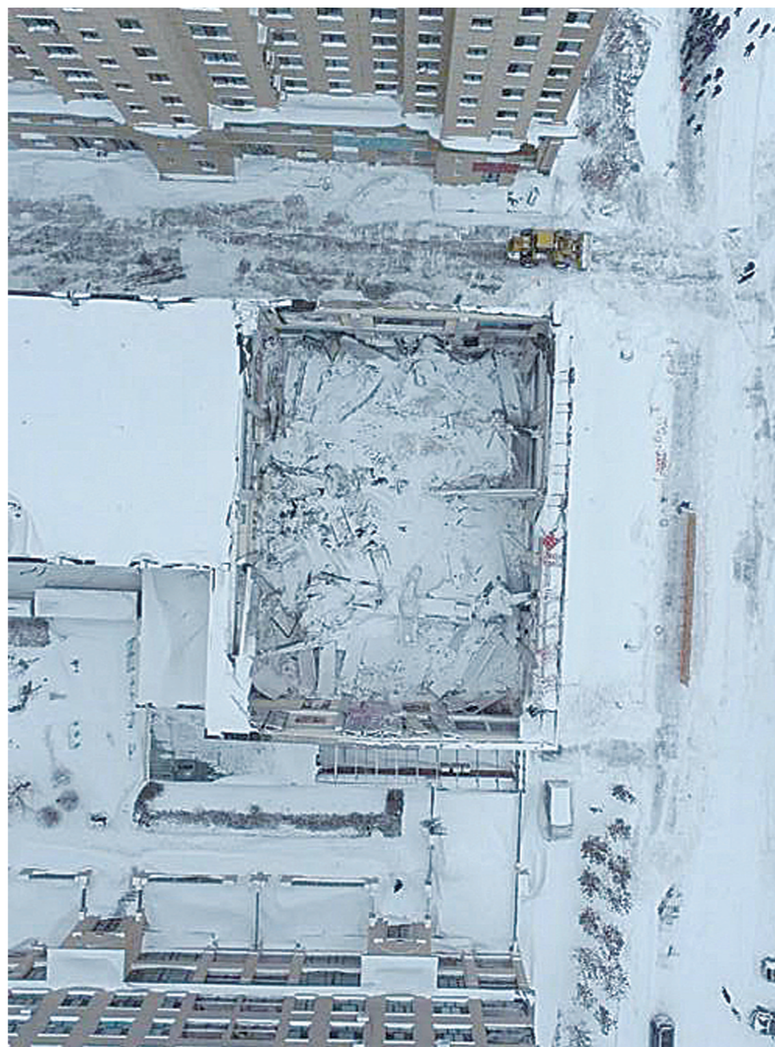
11月6日,佳木斯悦城体育馆屋顶坍塌。图据新华社
