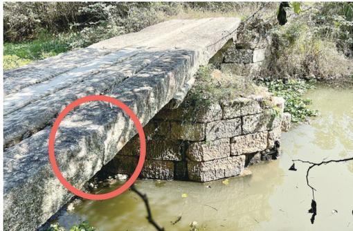
石梁桥桥墩,底部出现“悬空”现象,桥面的一根石梁(划红线处)出现断裂。记者/刘平 摄
