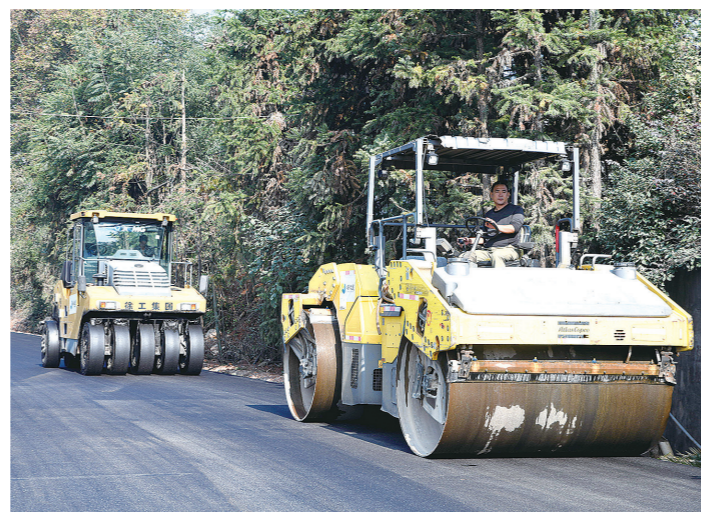
项目施工现场。通讯员/谷经华 供图
