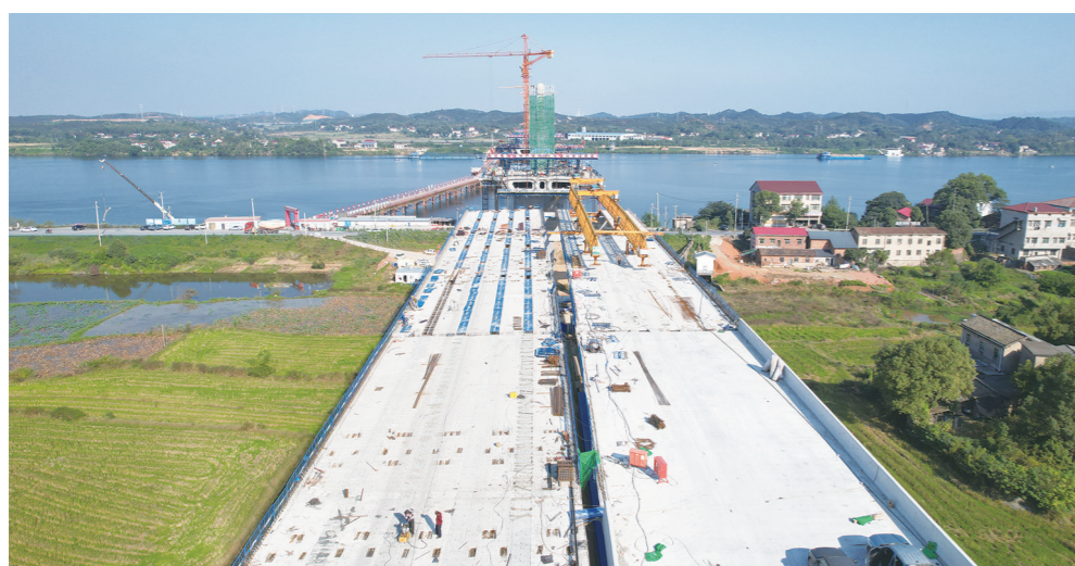
醴瓷高速株洲湘江特大桥引桥已架设完成。通讯员/郭慈珍 供图
