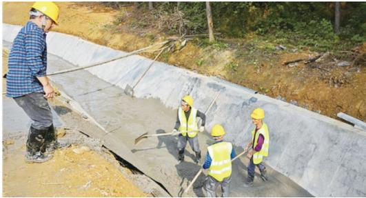
10月16日,在渌口区龙潭水库灌区,工人们趁着晴好天气加固灌溉渠道。今年9月,该灌区续建配套与节水改造工程开工,项目涉及龙潭、朱亭、龙门、涂田四镇,工程预计明年3月完工,届时可新增恢复灌溉面积0.59万亩,改善灌溉面积1.5万亩,新增粮食综合生产能力197万公斤,新增年节水能力194万立方米。
