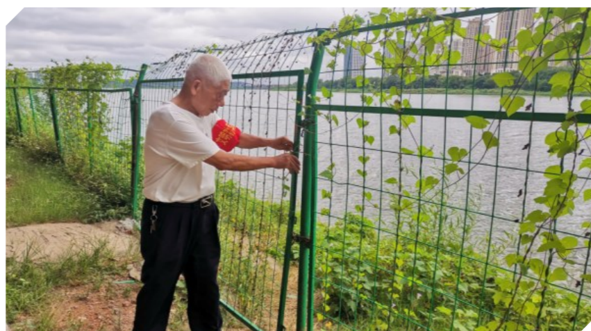
钟国民在修复湘江隔离防护栏。通讯员 供图
