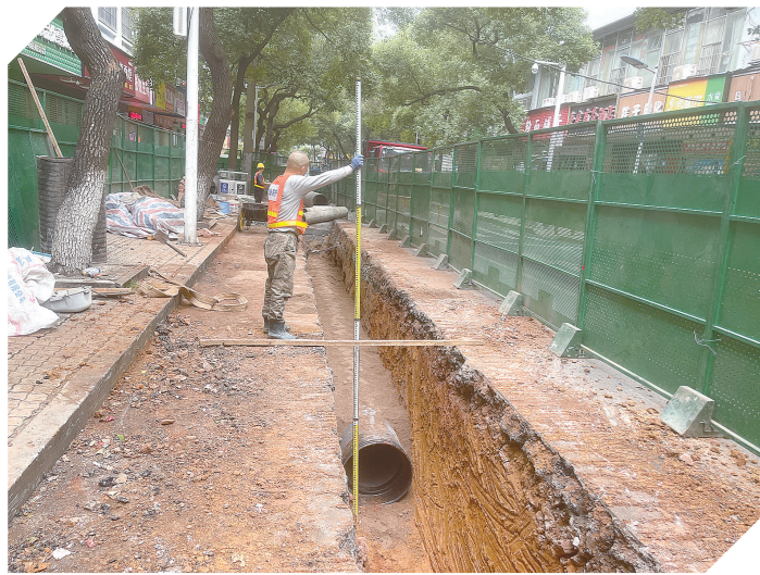
公园路正在进行排水专项改造,预计本月底完工。
