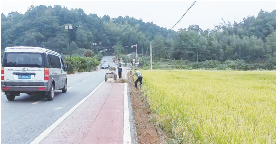
路政养护工人对农村道路进行养护。 通讯员 供图
