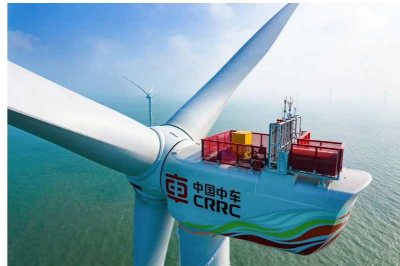
“海平面一号”海上风电机组。中车株洲所供图
