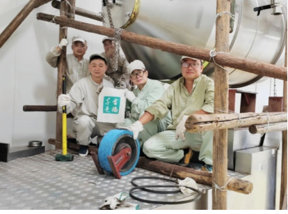
人物:千金药业河东制剂车间王庆 地点:河东制剂车间 感受:年休假期,河东制剂维修班全体人员加班维护保养车间设备,确保节后生产设备正常运转,这是我们的使命和职责。
