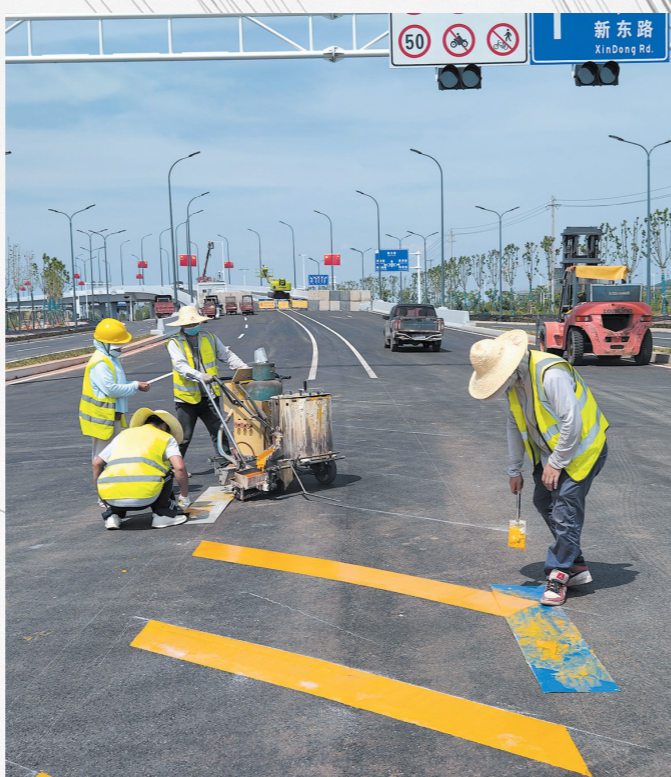
施工人员加紧施画交通标线
