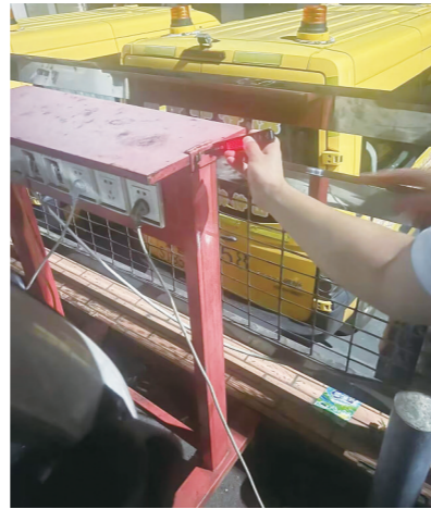
事发后,居民用试电笔检测充电桩,发现存在漏电。受访对象供图
