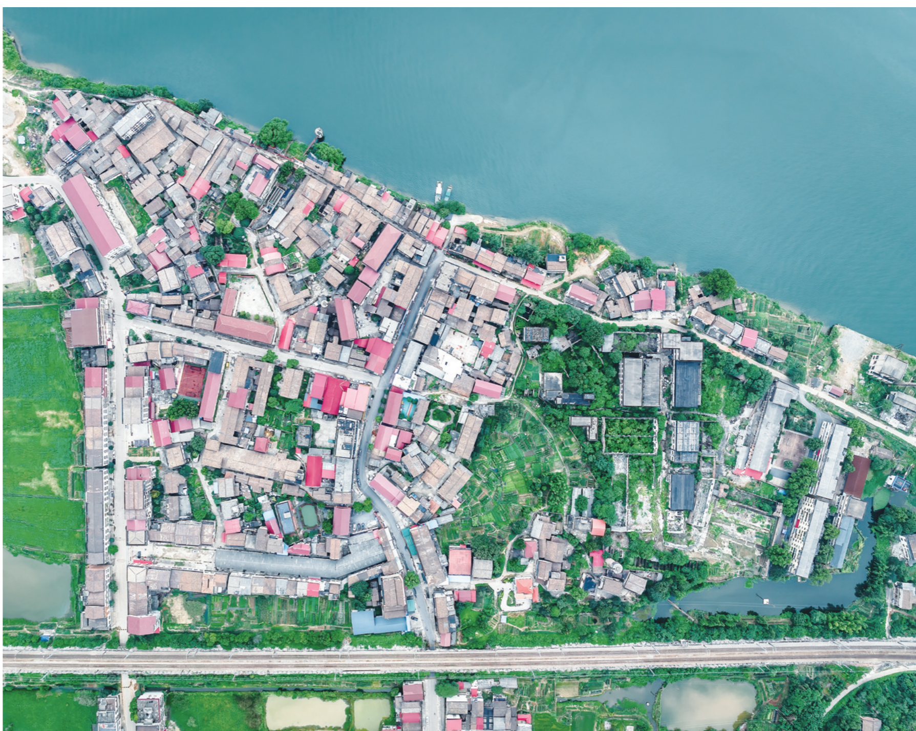
位于湘江东岸京广铁路西侧的淦田老街。咏洲 摄
