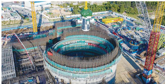
8月10日，海南昌江，全球首个陆上商用模块化小堆“玲龙一号”反应堆核心模块吊装成功。“玲龙一号”集成压力容器、蒸发器、主泵接管，并取消了主管道。除发电外，同时还具有热电联供、水电联供、城市区域供热等多用途。该项目建成投运后，预计每年发电量可达10亿度，每年可减少二氧化碳排放量约88万吨。(中新社记者 骆云飞 摄)
