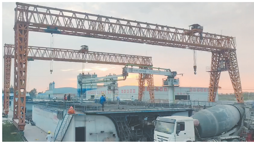
包银铁路银川制梁场最后一根箱梁制作现场。通讯员/徐雅萍 供图
