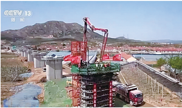
莱莱高铁施工现场。
